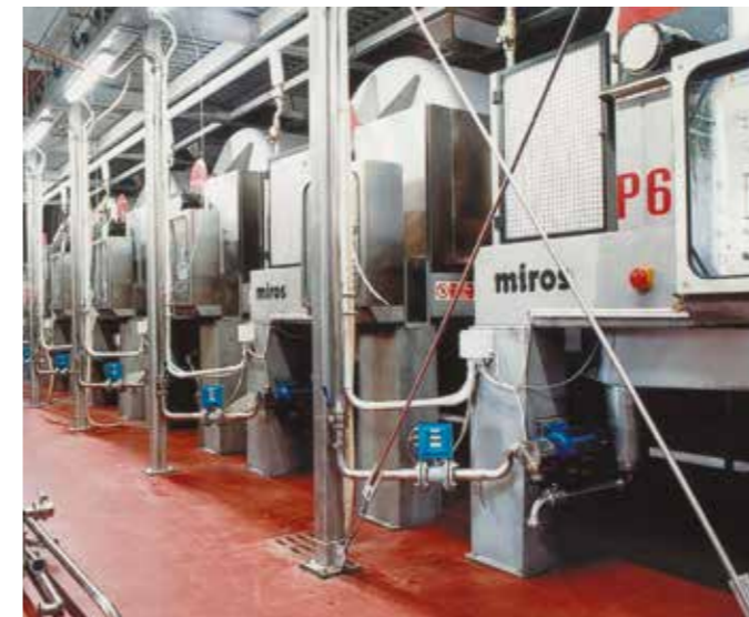
IMPIANTO AUTOMATICO GESTIONE MOSTI
